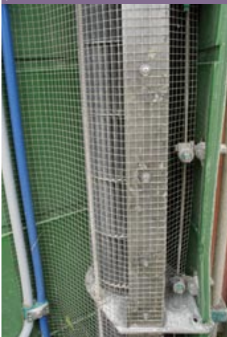
La turbine tangentielle et la rampe de pulvérisation.
