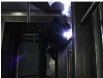
Kellerschweißung im Weingut Weil, Kiedrich
